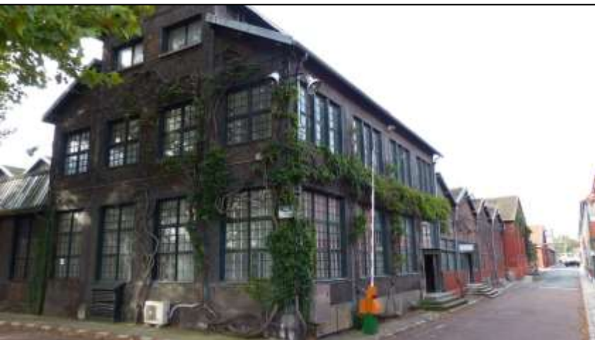
Usine de l'orfèvrerie Christofle à Saint-Denis – Plan local d'urbanisme intercommunal de Plaine Commune
