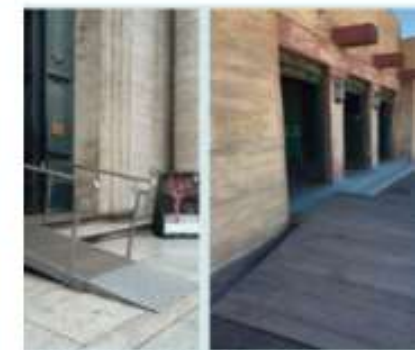
Plataformas permanentes en accesos a edificios monumentales de tipo "sobrepuestas"
