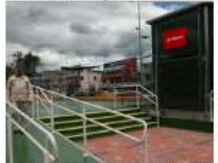
...rampas para el ingreso de personas con movilidad reducida a las e...
