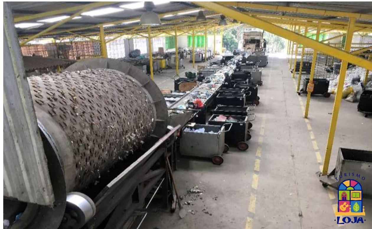
Planta de Reciclaje (Área de separación )
